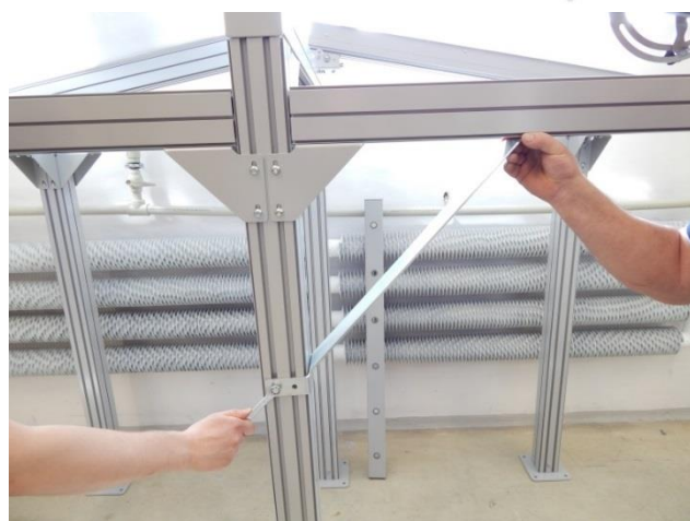
rys. 25. Montaż zastrzałów.
