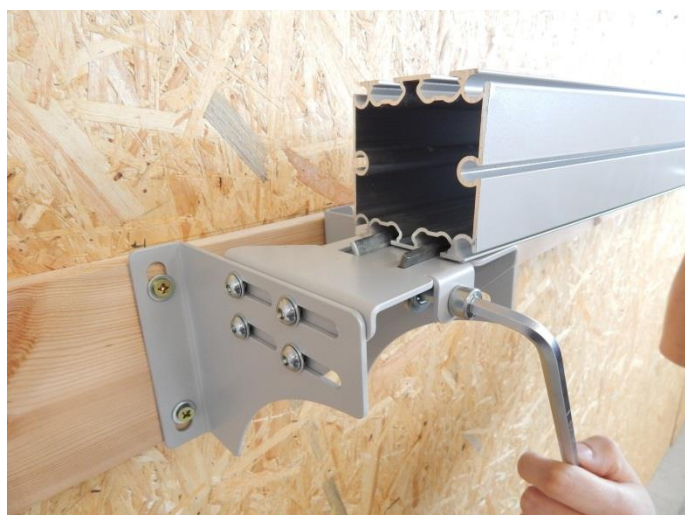
rys. 9. Mocowanie belki przyściennej na uchwycie przyściennym.
