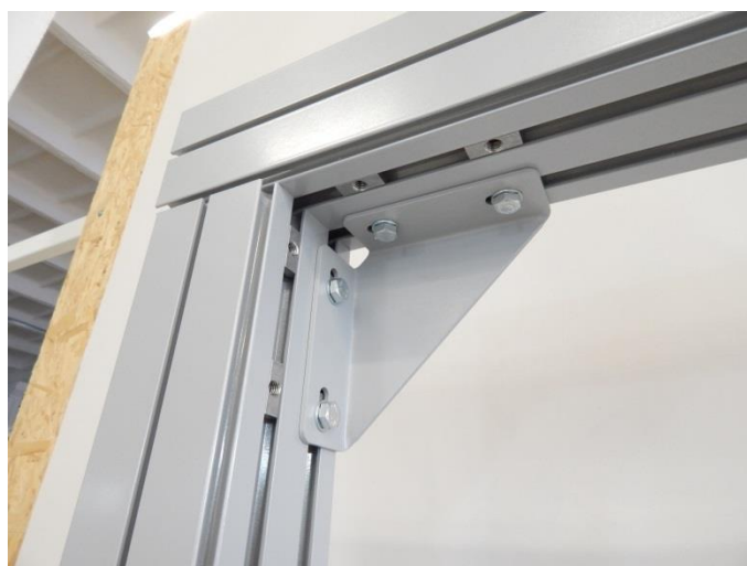
Rys. 15. Sposób zamontowania łącznika kąтового
