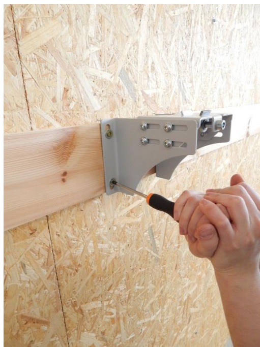
rys. 6. Przykręcanie i korekta wysokości zamocowania uchwyty przyściennego.
