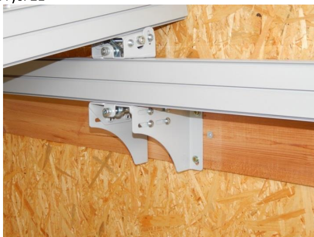
rys. 21. Połączenie belki poziomej i krokwiowej
