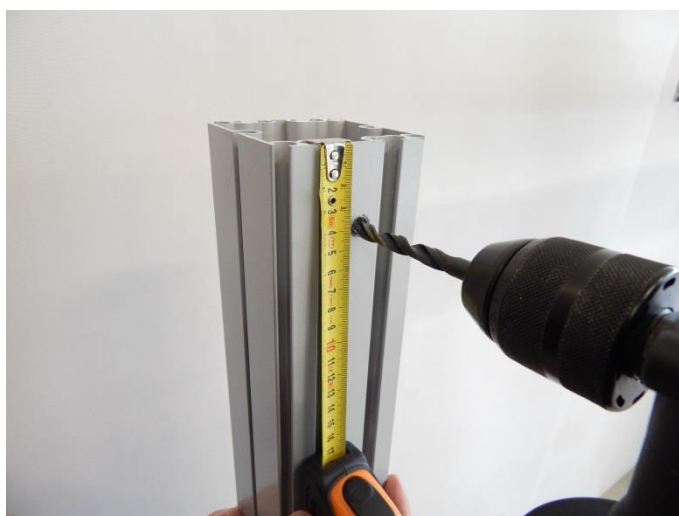
rys. 11. Owiercanie słupa pergoli
