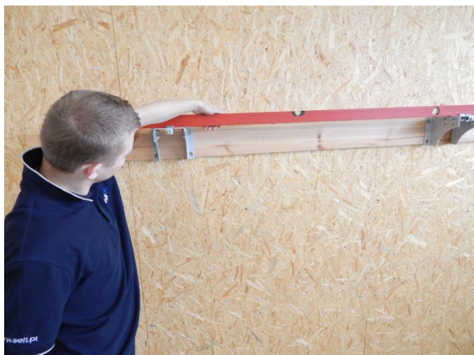
rys. 7 – Poziomowanie uchwytów przyściennych.
